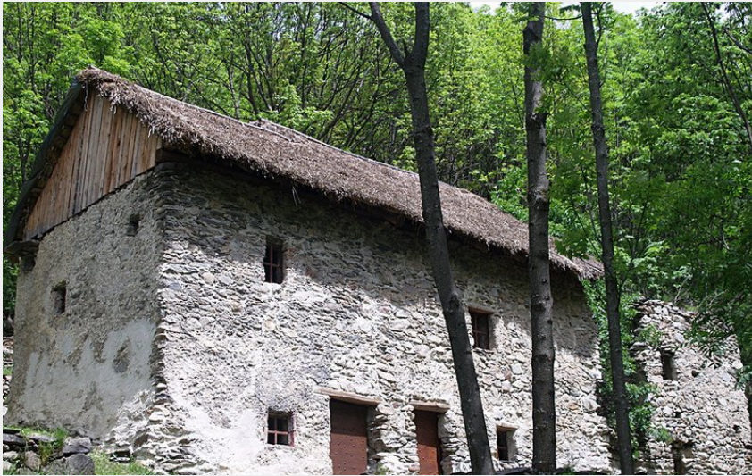
La casa a Tetti Bartola con tetto in paglia di segale (Roberto Pockaj)
