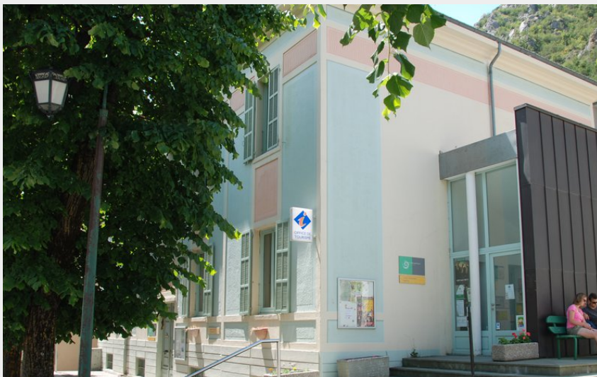
Credito fotografico : Extérieur de la Maison du Parc à Tende (DR / PnM)
